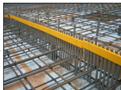
棧木にスラブフェンス極を結束線で固定
